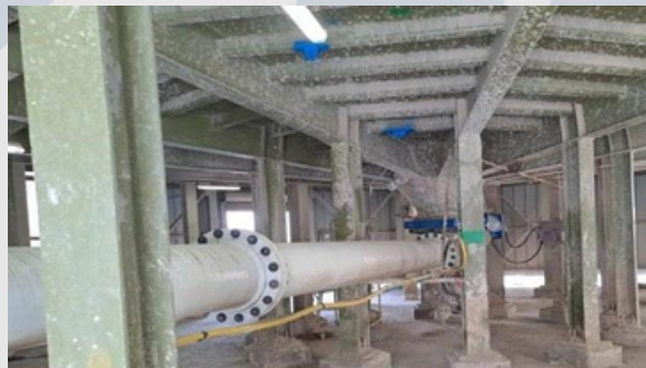
Montaje de cañerías
