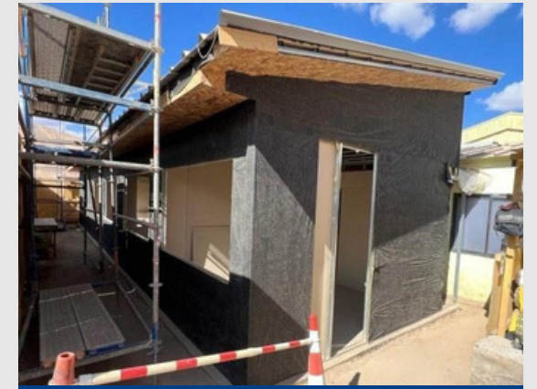
Construcción de oficinas
