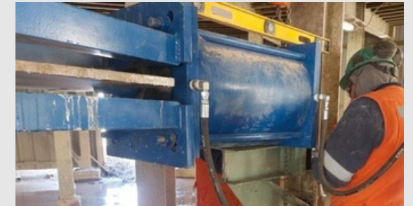
Instalación de válvulas
