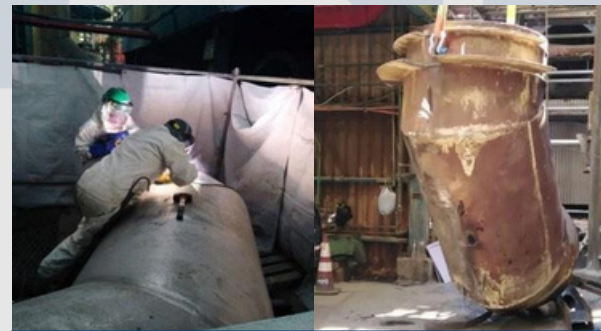
Reparación y remplazo de ductos
