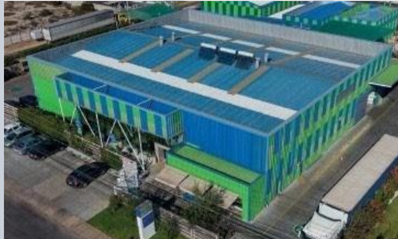
Planta industrial de agua
