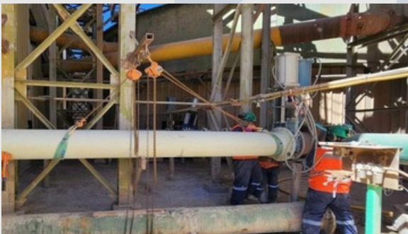
Fabricación de cañerías
