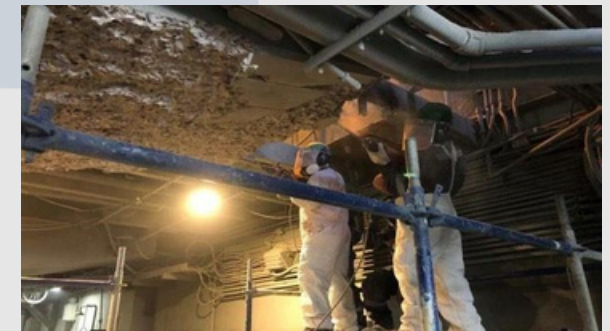
Reparación de infraestructura
