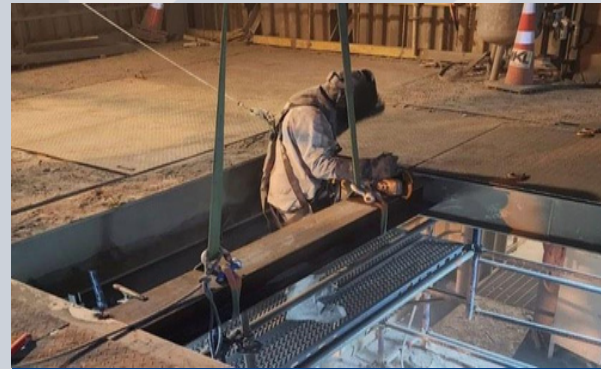
Fabricación de estructuras
