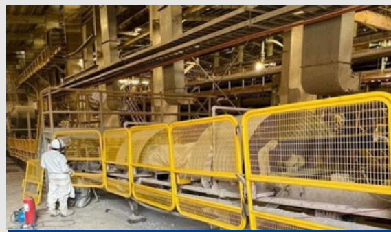
Montaje de estructuras
